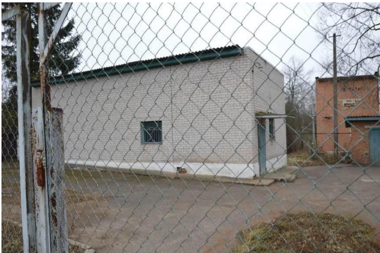
Рисунок 13 – Общий вид главной канализационной насосной станции
